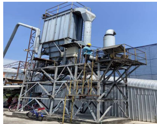
รูปที่ 2.1-31 : เจ้าหน้าที่ตรวจสอบระบบดักฝุ่นแบบถุงกรองที่จุดปลายทางสายพานลงเรือ
