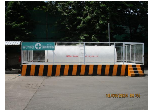
รูปที่ 2.1-96 : คันคอนกรีตล้อมรอบถังเก็บน้ำมันดีเซล
