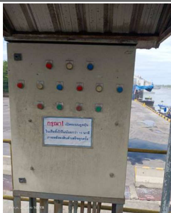
รูปที่ 2.1-32 : ป้ายแจ้งให้พนักงานเปิดระบบดูดฝุ่นในเรือต่อเนื่องไม่น้อยกว่า 15 นาทีภายหลังลงสินค้าแล้วเสร็จทุกครั้ง
